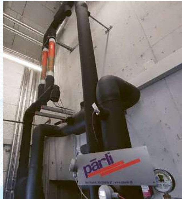
Installation chez Fanuc
