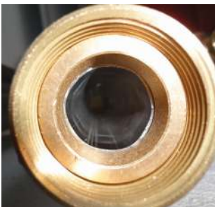
Tube de contrôle monté sur l'eau chaude avant l'installation de l'Aqua4D®
