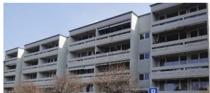
Installation dans un bâtiment en copropriété dans le canton de Berne.
