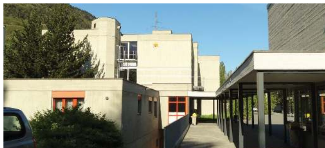
Installation dans un bâtiment public de l'école professionnelle à Viège en Valais.
