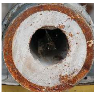
Inspection de l'état de la tuyauterie avant l'installation du système Aqua4D®.
